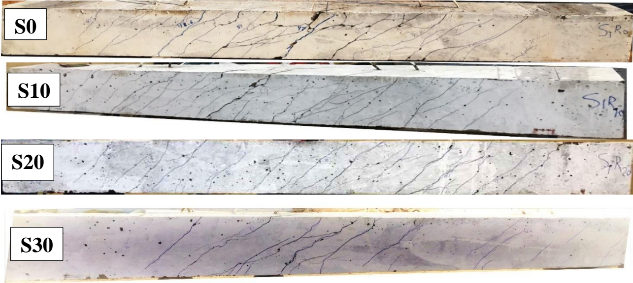
Figure 8. R.C. beam crack patterns : (a) S0 , (b) S10, (c) S20, (d) S30
